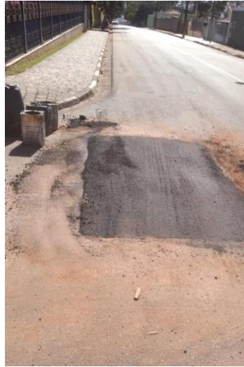
Figura 29 - Vala já fechada no local da escavação para realização da intervenção 05 no setor 13 – Filtro Velho
