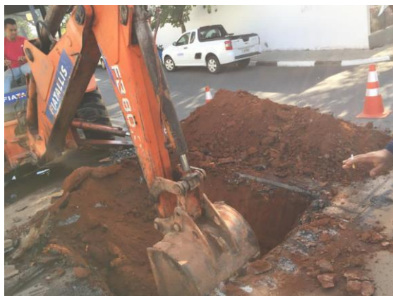
Figura 22 - Registro do início da escavação na intervenção 04 do setor 13 – Filtro Velho
