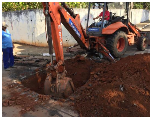
Figura 23 - Registro da escavação para execução da intervenção 04 no setor 13 – Filtro Velho
