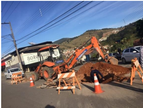
Figura 44 - Início dos trabalhos na intervenção 01 no setor 15 – São Marcos
