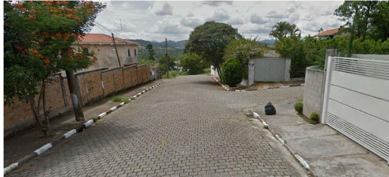
Figura 31 - Local da intervenção 06 no setor 13 – Filtro Velho
