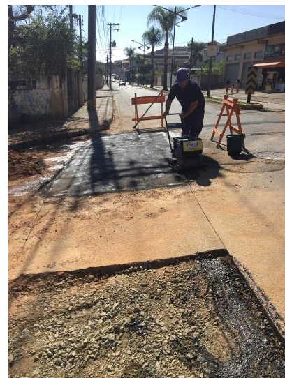
Figura 49 - Pavimentação sendo executada na intervenção 01 no setor 15 – São Marcos
