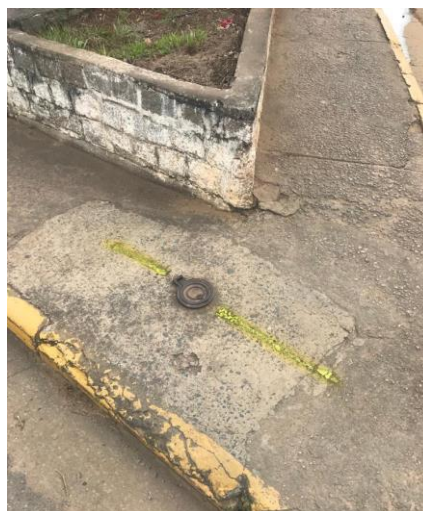
Figura 18 - Local da intervenção 02 no setor 13 – Filtro Velho
