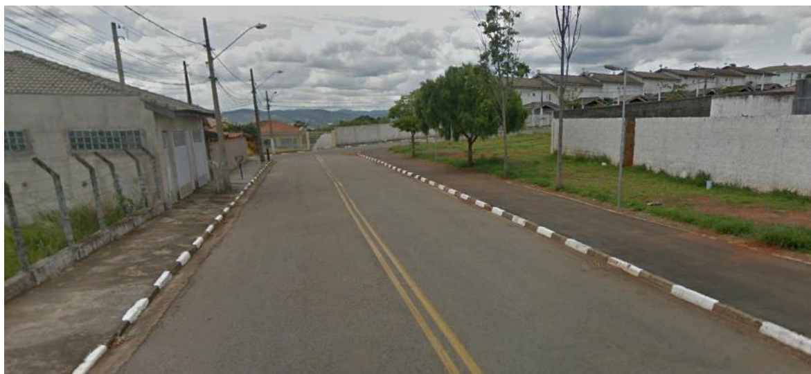
Figura 41 - Local onde deveria ser executada a intervenção 01 no setor 14 – ETA
