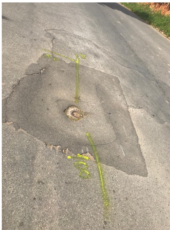
Figura 13 – Local da intervenção 02 no setor 09 – Hortência
