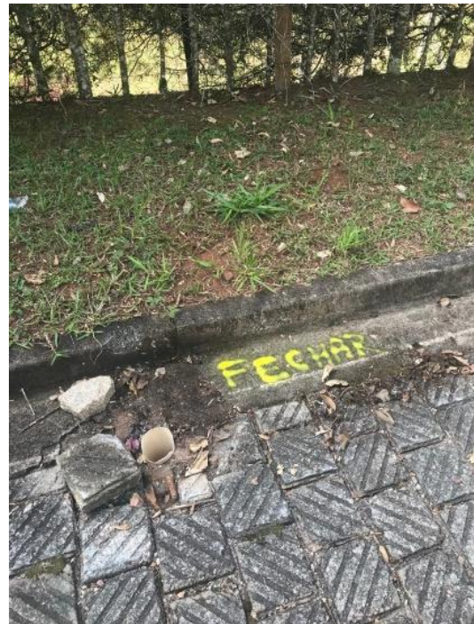
Figura 59 - Local de fechamento do registro 2 previsto na intervenção 03 do setor 15 – São Marcos
