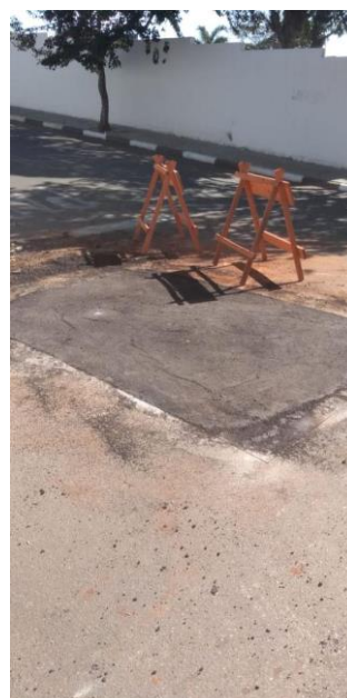
Figura 25 - Vala já fechada no local da escavação para realização da intervenção 04 no setor 13 – Filtro Velho
