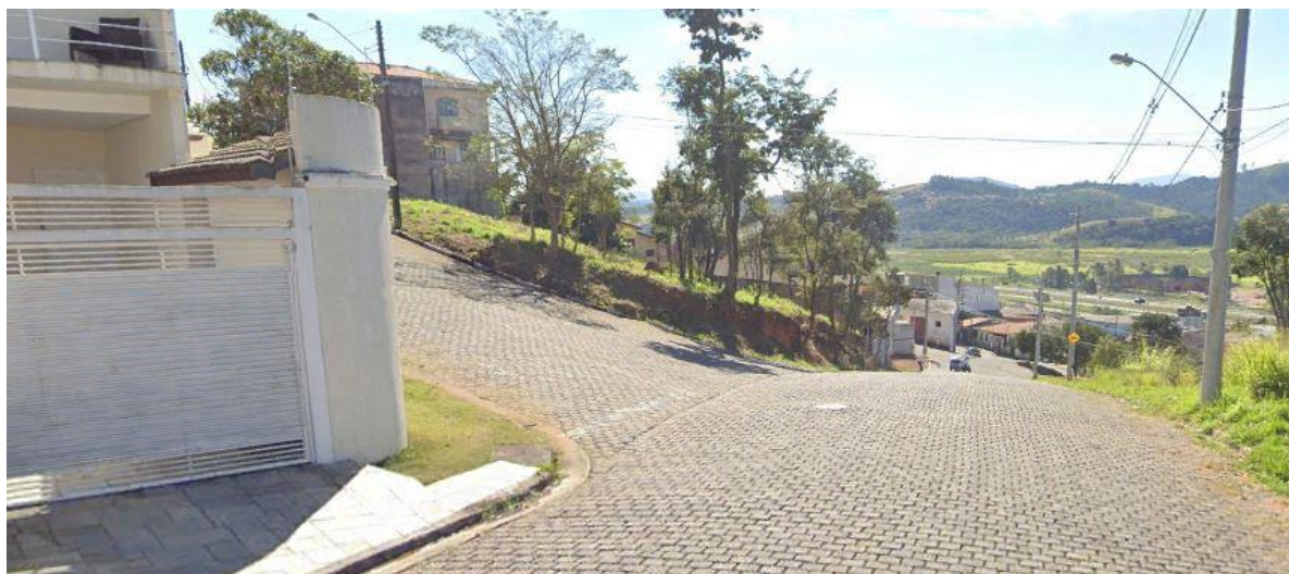
Figura 33 - Local da intervenção 07 no setor 13 – Filtro Velho
