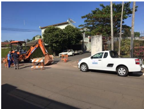
Figura 27 - Local da intervenção 05 no setor 13 – Filtro Velho
