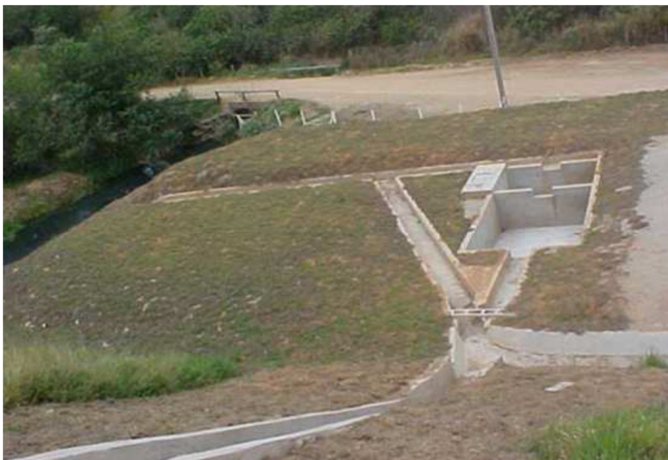
Figura 13. Caixa de retenção difusa proposta no presente trabalho.
