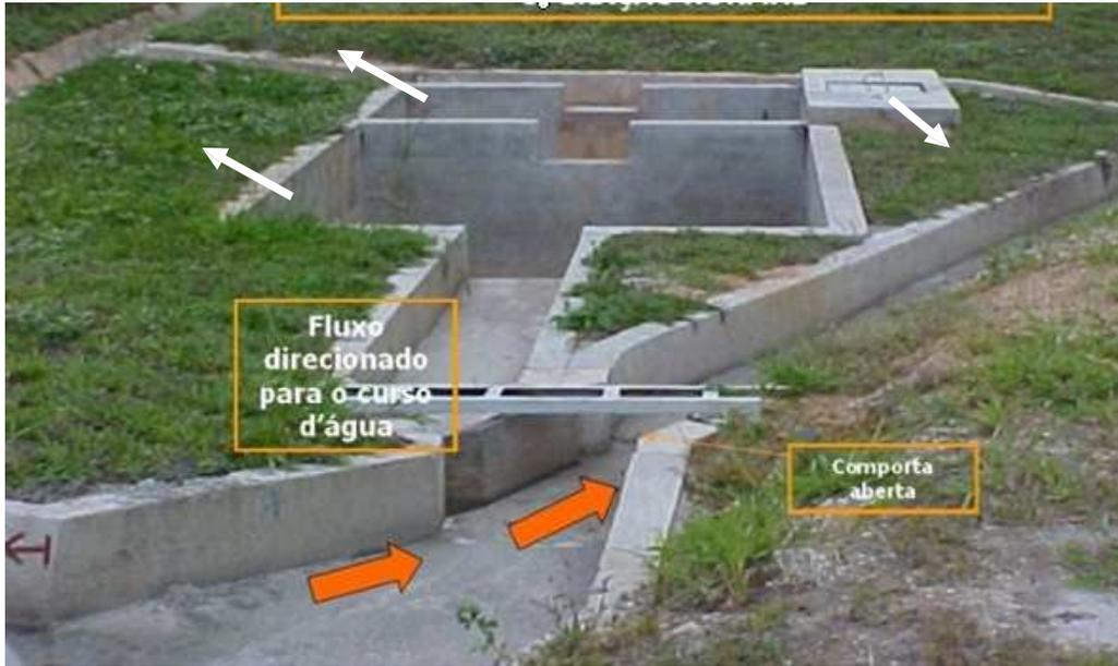
Figura 06. Vista da caixa de retenção difusa na operação normal de drenagem, ou seja, sem passar pelo compartimento de decantação.
