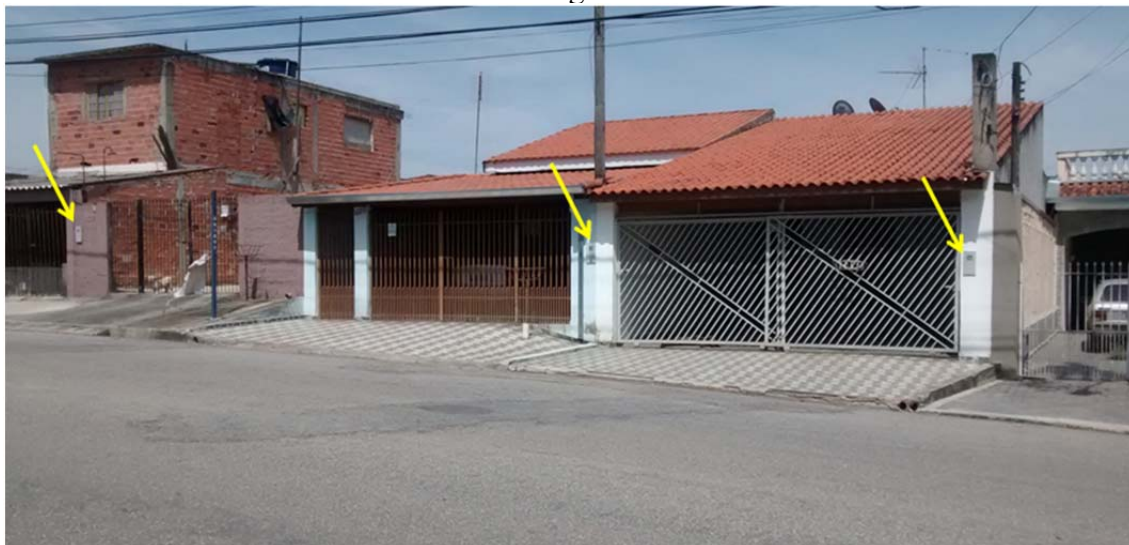
Figura 31. Vistas de hidrômetros instalados na vertical existentes no sistema de abastecimento de água de Votorantim.
