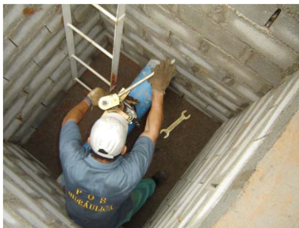
Figura 9. Perfuração da tubulação.
