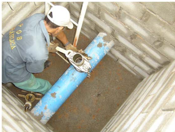
Figura 6. Colocação do suporte da máquina Muller.
