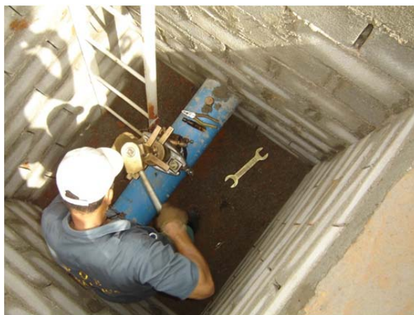
Figura 11. Momento em que a EP está sendo rosqueada na tubulação.
