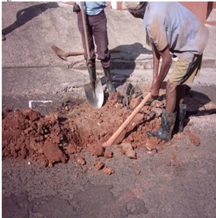
Figura 50. Abertura de vala no local indicado de vazamento
