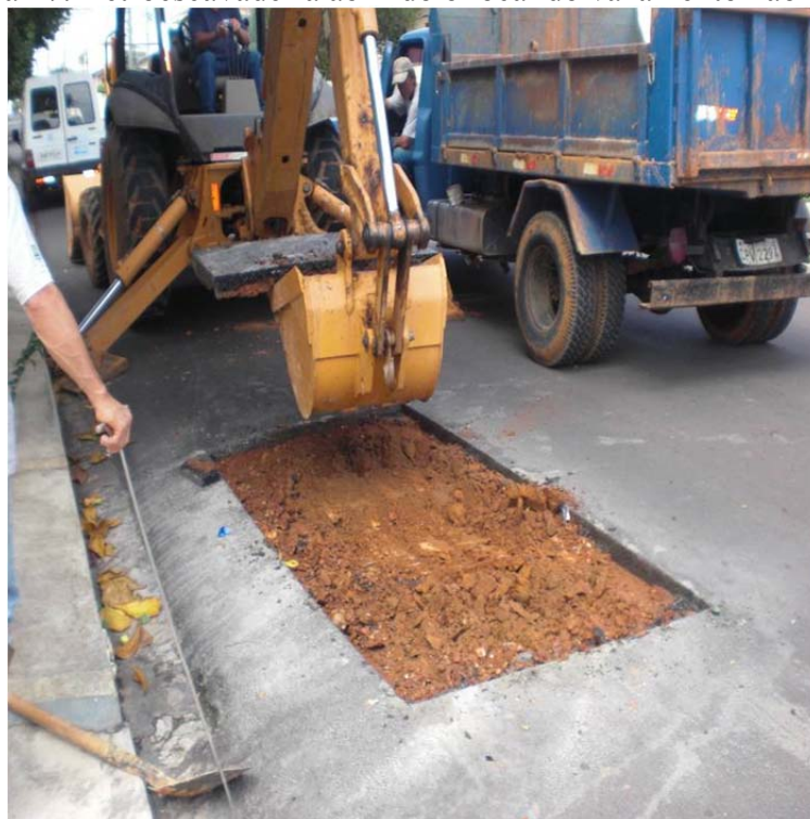
Figura 47. Retroescavadeira abrindo o local do vazamento não visível
