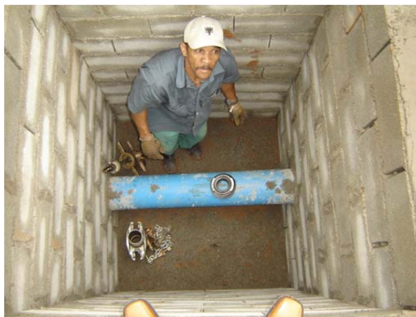
Figura 5. Colocação do anel de borracha na tubulação.
