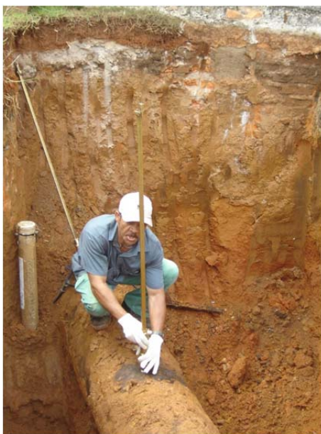
Figura 12. Medição do diâmetro real da adutora.
