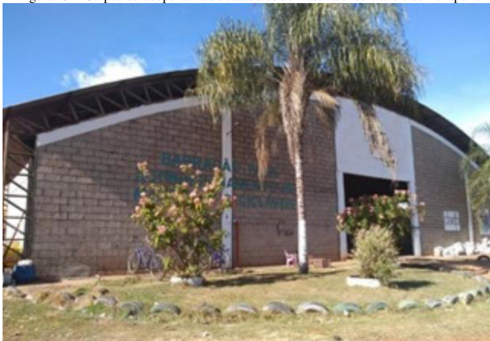
Figura 19 – Galpão da cooperativa de catadores de materiais recicláveis de Penápolis
