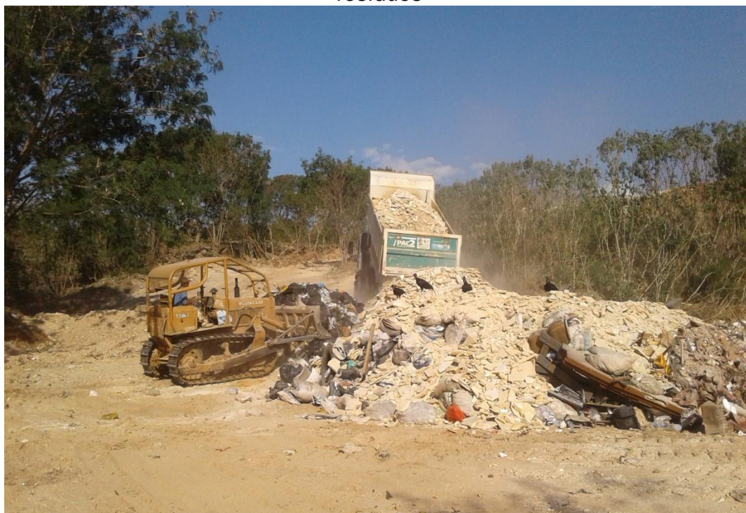
Figura 27 - Descarte dos RSU recolhidos na cidade de Alpinópolis no aterro controlado: caminhão basculante despejando cascalho para cobrir os sacos de resíduos
