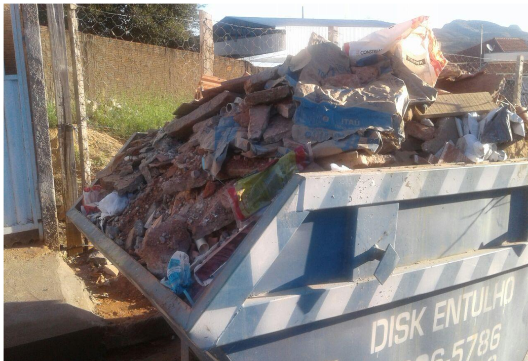
Figura 84 - RCC descartados em caçambas de empresa de setor privado no local do estudo
