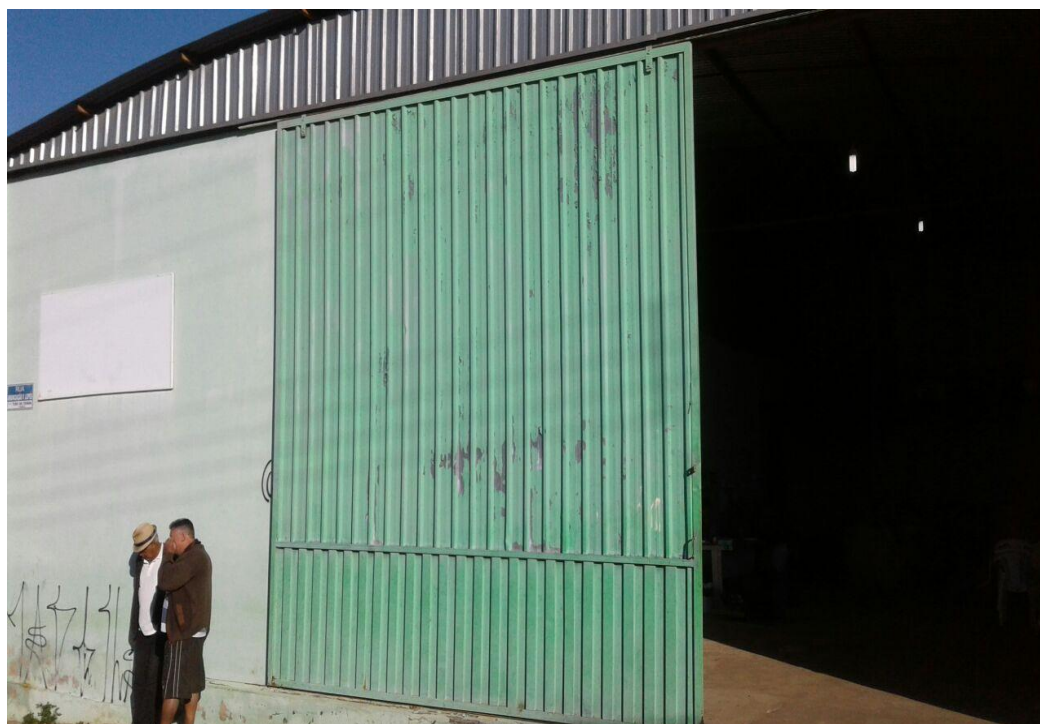
Figura 29 - Entrada do galpão onde funciona o projeto de reciclagem “Ventania e Cidadania” administrado pela prefeitura e coordenado pela assistência social
