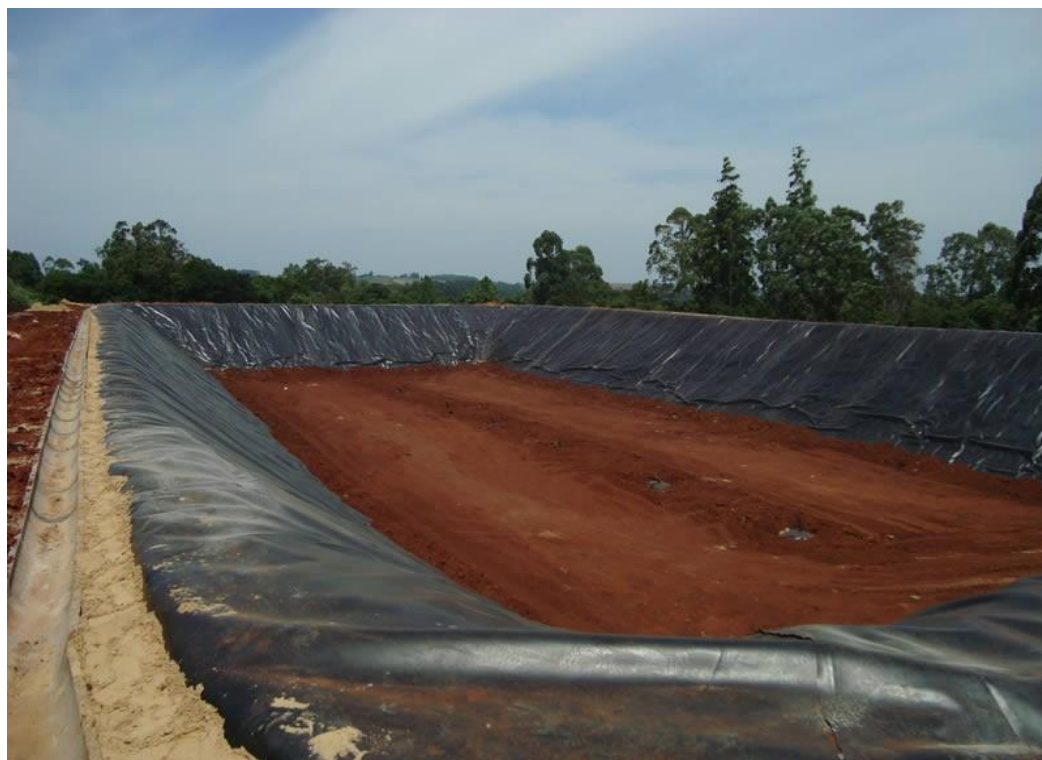
Figura 6 - Sistema de impermeabilização de um aterro sanitário
