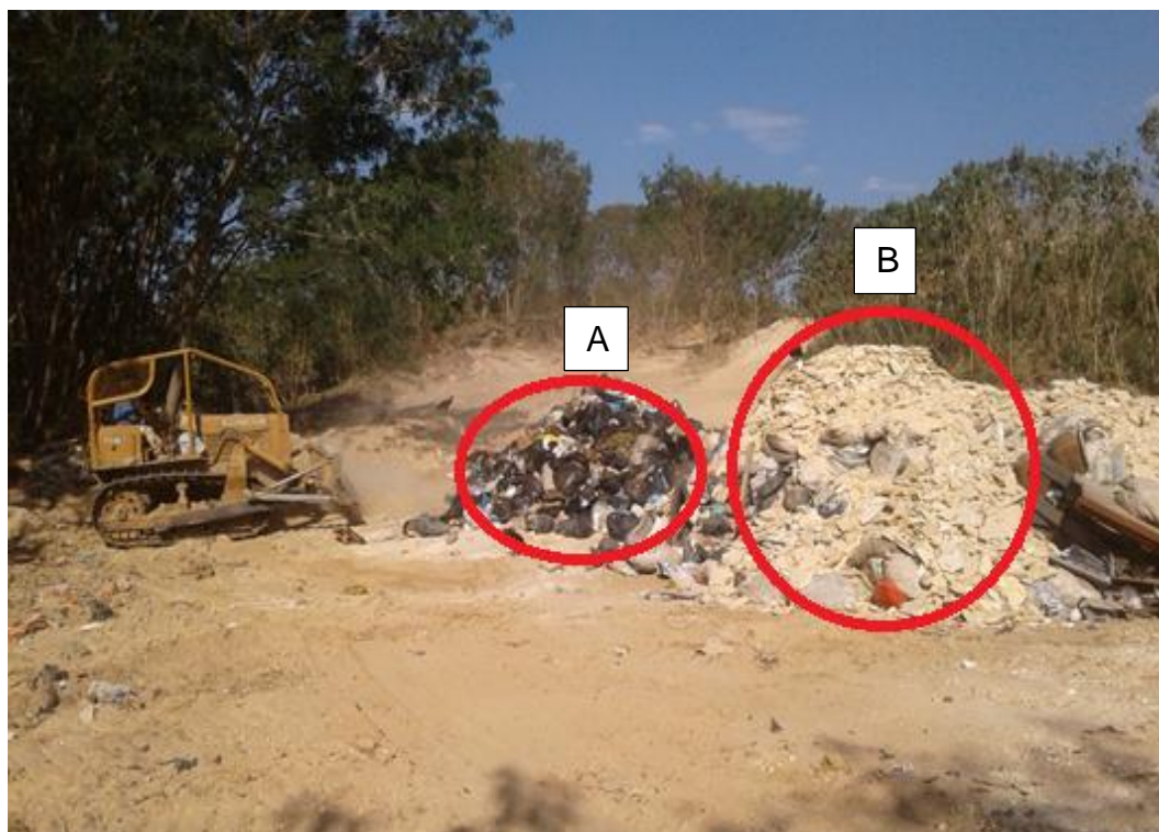
Figura 26 - Descarte dos RSU recolhidos na cidade de Alpinópolis no aterro controlado: A- sacos de resíduos; B- cascalho usado para cobrir os sacos de resíduos
