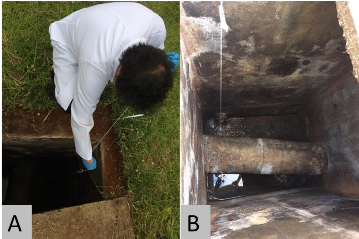
FIGURA 6 – Coleta das amostras no hospital secundário de Ribeirão Preto, SP. A) Caixa de passagem do esgoto. B) Interior da caixa de passagem
