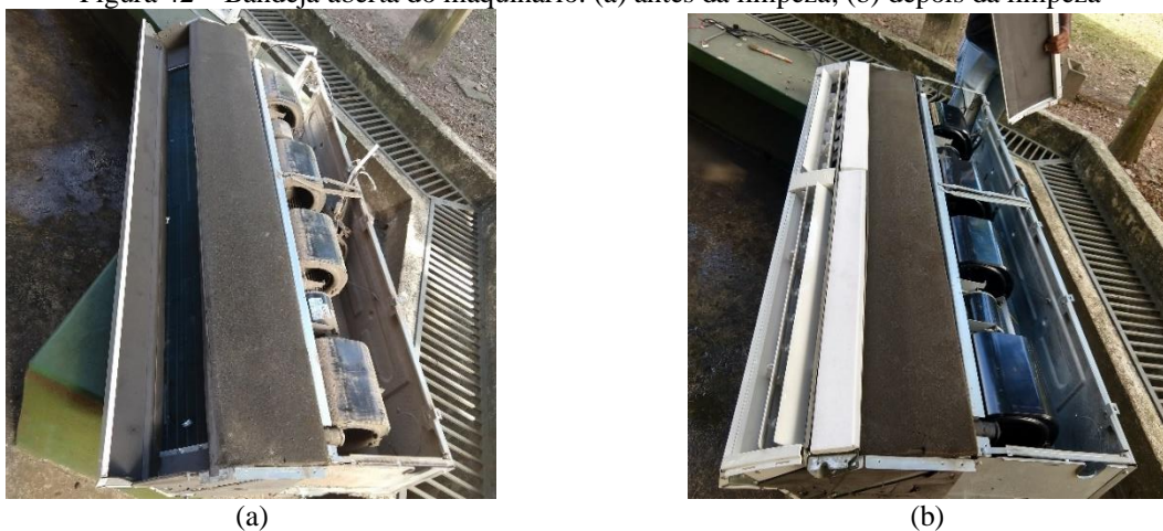
Figura 42 – Bandeja aberta do maquinário: (a) antes da limpeza; (b) depois da limpeza
