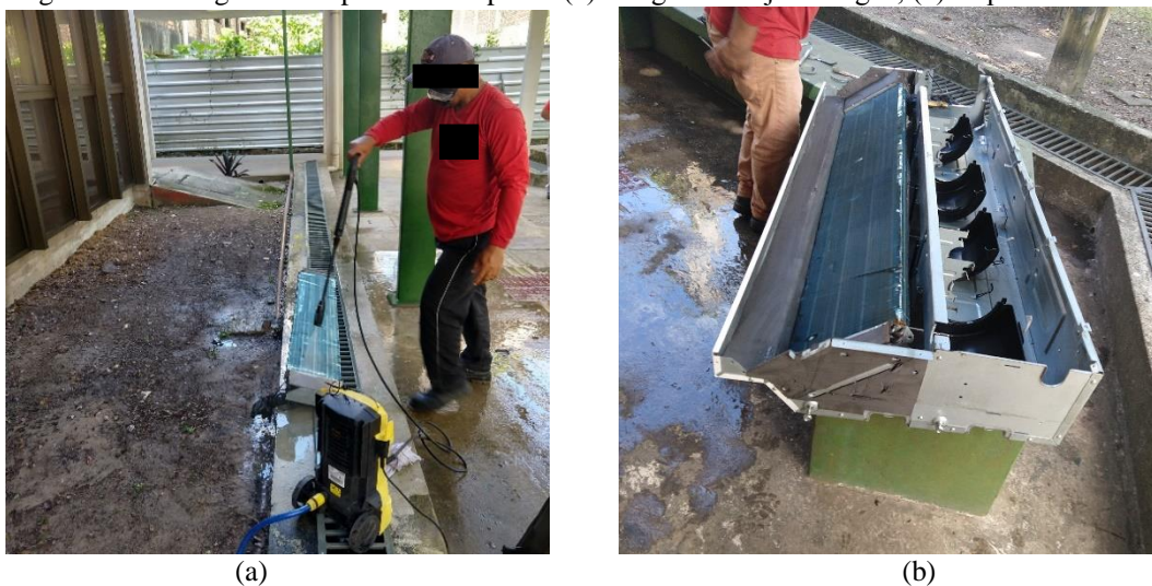
Figura 43 – Lavagem da serpentina do Split 1: (a) lavagem com jato d'água; (b) serpentina lavada
