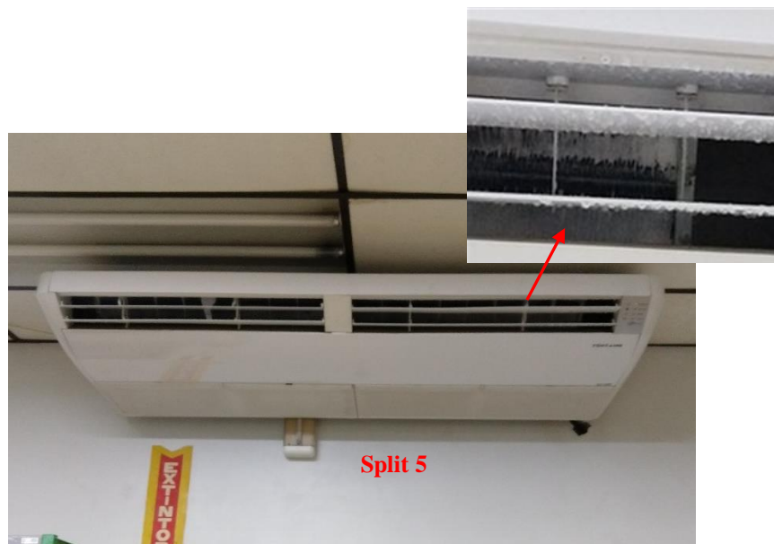
Figura 24 – Produção de gelo no Split 5 localizado na entrada do acervo da Biblioteca
