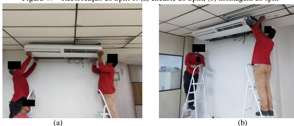
Figura 47 – Recolocação do Split 1: (a) encaixe do Split; (b) montagem do split
