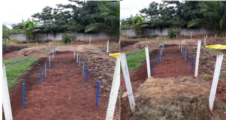
Figura 23: Montagem das leiras
