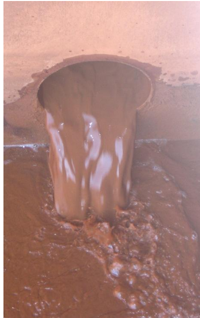
Figura 3: Disposição inadequada de lodo de ETA.
