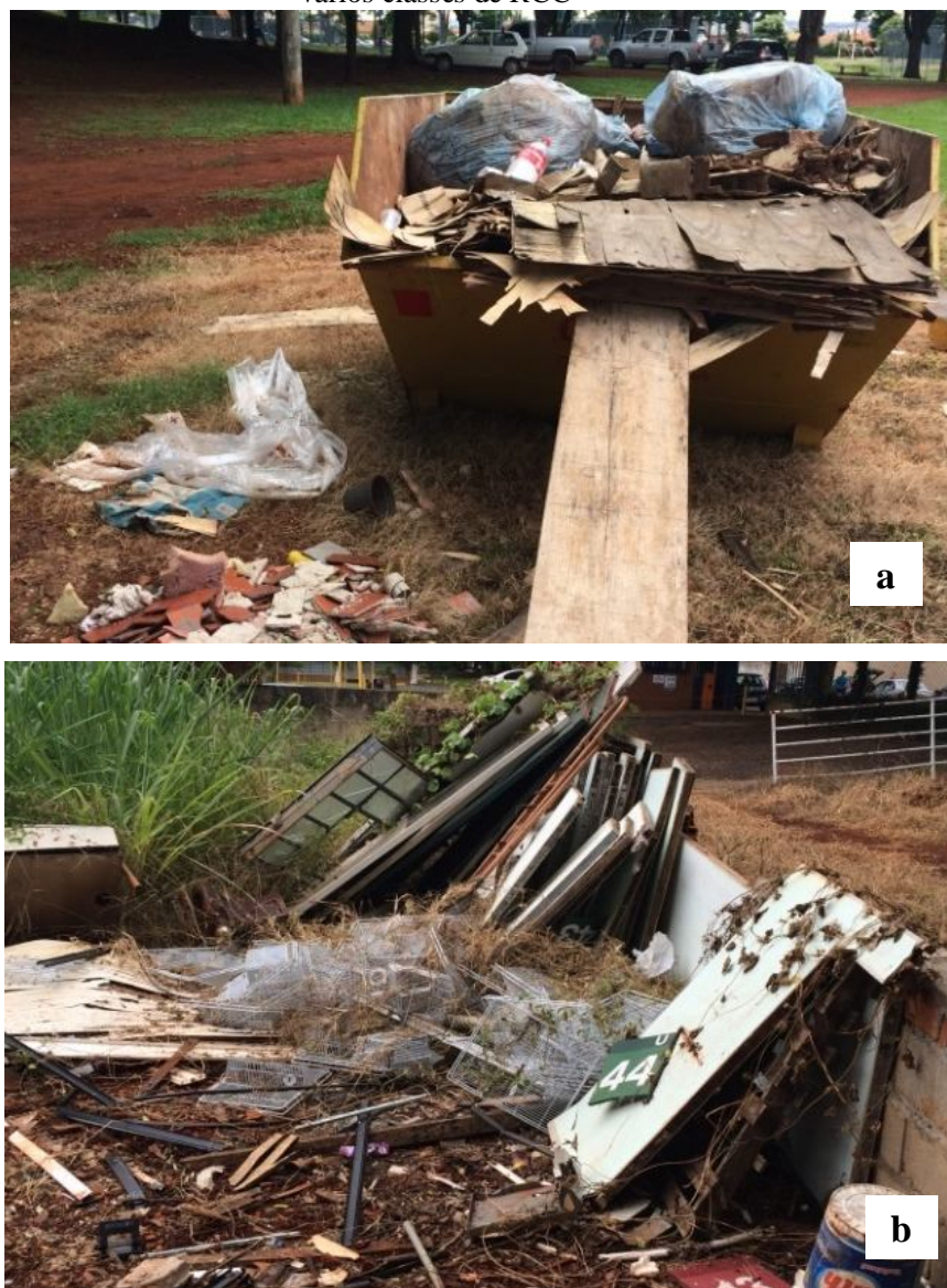
Figura 32 - Canteiro de obras com RCC da IES correspondendo ao ponto gerador K conforme o mapa do campus - a) caçamba estacionária com diversos RCC, b) baía de descarte com vários classes de RCC
