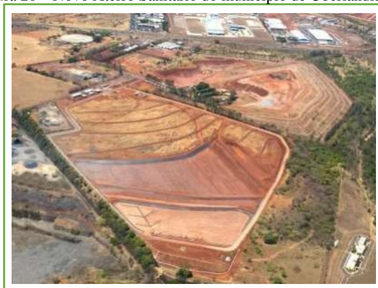
Figura 20 – Novo Aterro Sanitário do município de Uberlândia-MG
