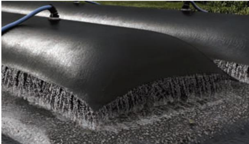
Figura 17 – Bag de Geotecido durante o bombeamento
