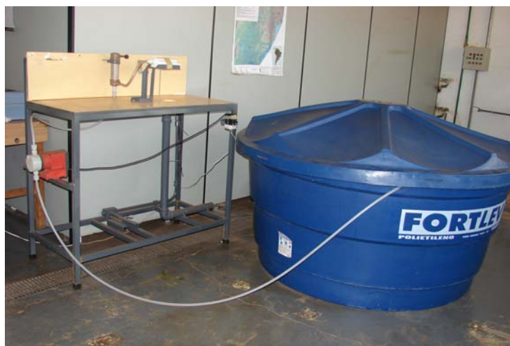
Figura 4.9 Instalação piloto para realização dos ensaios com o FCAIP
