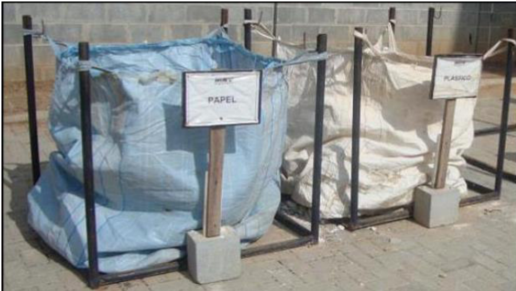
Figura 7. “Big-bags” para coleta de resíduos sólidos em canteiro de obras na cidade de Ribeirão Preto - SP
