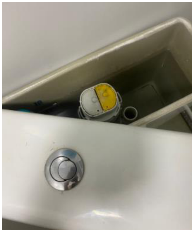
Figura 10. Caixa acoplada com sistema duplo de descarga
