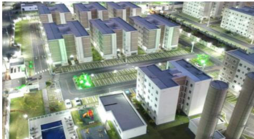
Figura 11. Empreendimento com luminárias de LED
