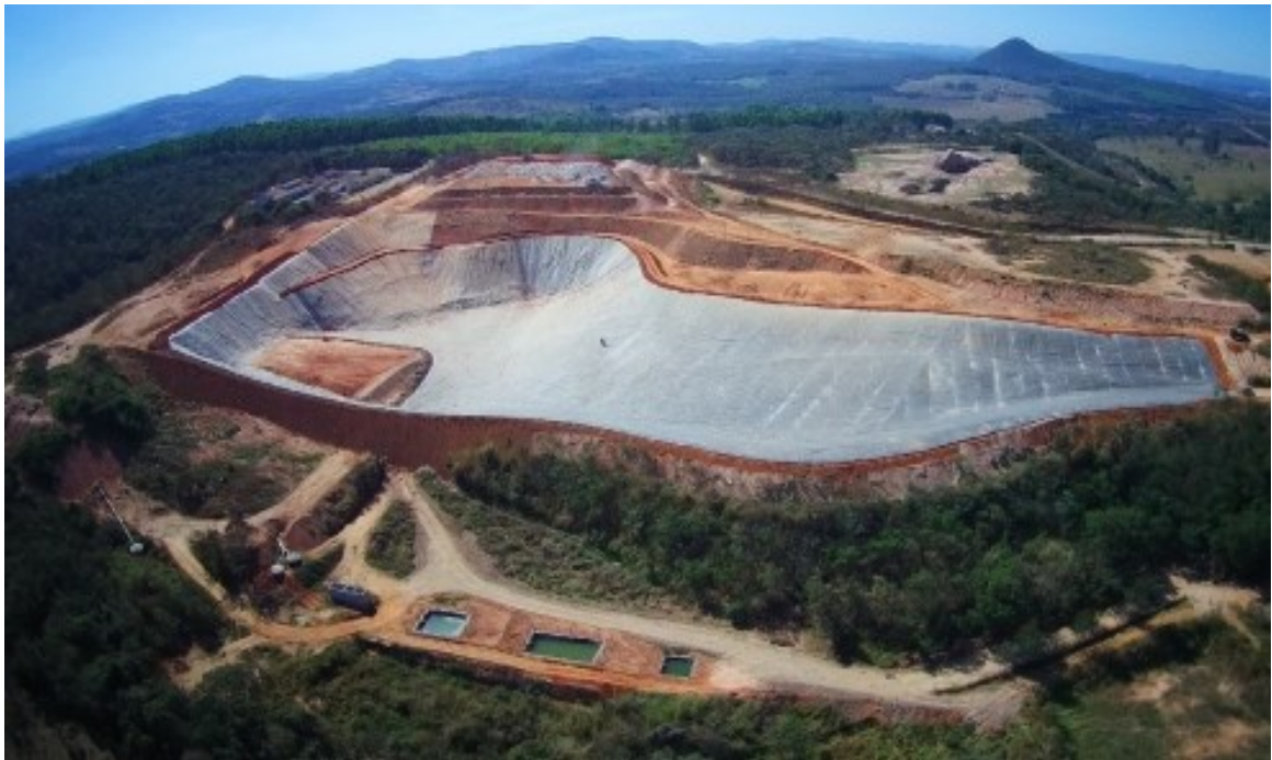
Figura 10 - Aterro controlado no município de Divinópolis/MG
